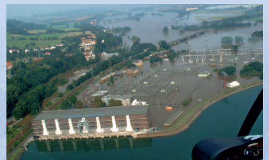
Pumpspeicherwerk Niederwartha, August 2002
